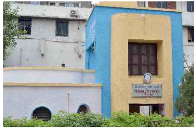
Pa y & Use Toilet
